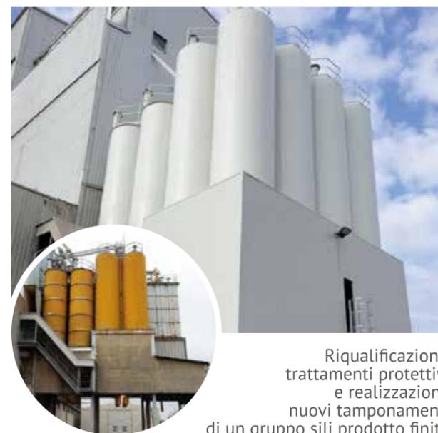
Riqualficazione, trattamenti protettivi e realizzazione nuovi tamponamenti di un gruppo silos prodotto finito
