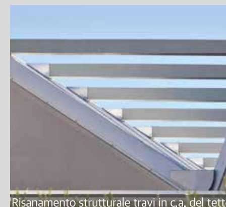
Risanamento strutturale travi in c.a. del tetto
