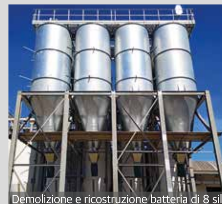
Demolizione e ricostruzione batteria di 8 silos
