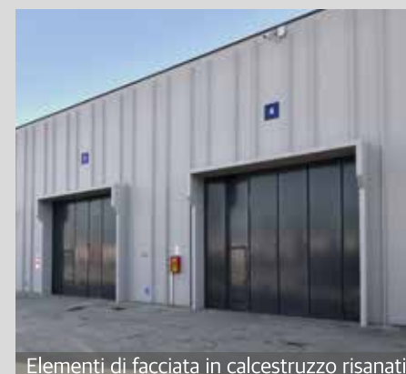
Elementi di facciata in calcestruzzo risanati
