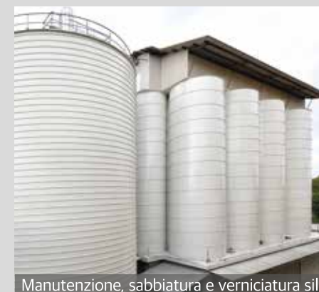
Manutenzione, sabbiatura e verniciatura silos
