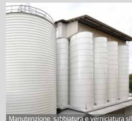
Manutenzione, sabbiatura e verniciatura silos
