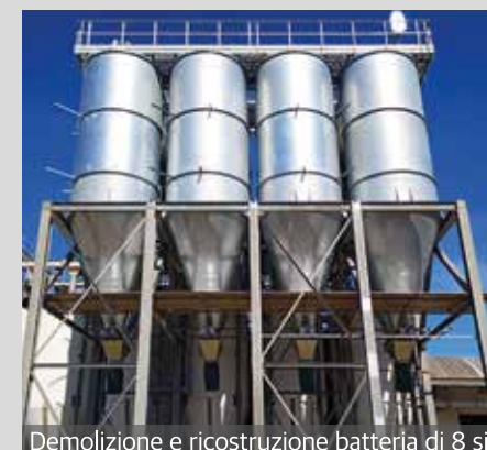
Demolizione e ricostruzione batteria di 8 silos
